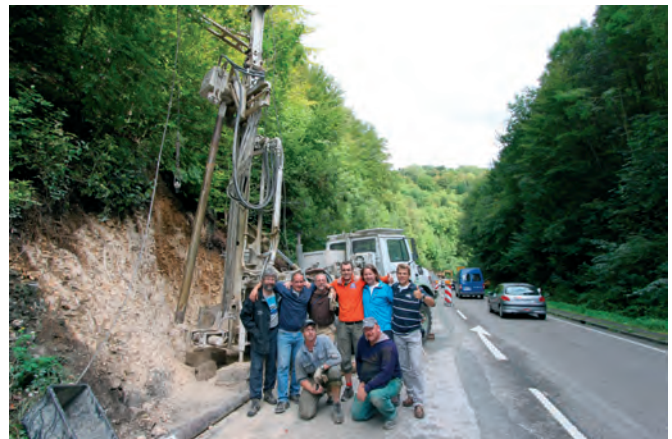
Abb. 3: Bohrung über dem Stairway to Heaven
