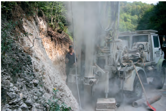
Abb. 2: Bohrung über dem Stairway to Heaven
